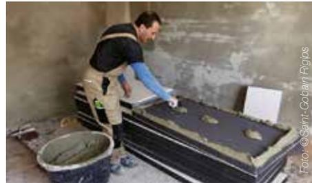
Abb. 2 Bei Hartschaumplatten wird die Klebefuge im Punkt-Wulst-Verfahren ausgeführt. Dadurch wird die Luftschicht-mehrteilung gegliedert, um eine Hinterströmung der Dämmung (Konvektion) zu vermeiden.
