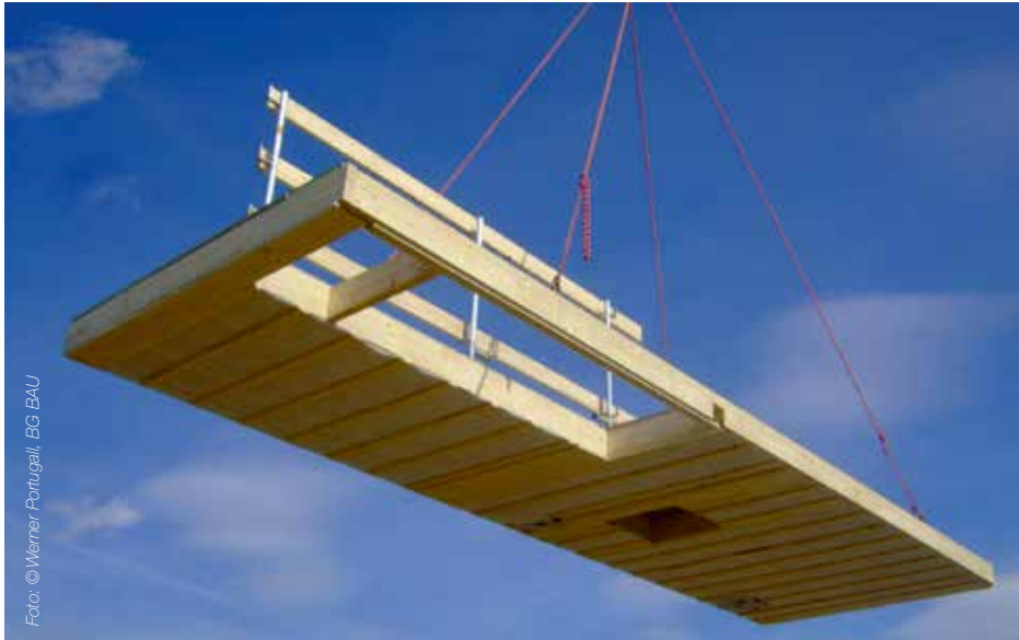
Abb. 4: Ein bereits am Boden angebrachter Seitenschutz steht sofort nach Verlegung des Deckenelements zur Verfügung und verhindert zuverlässig einen Absturz durch das Treppenloch.
