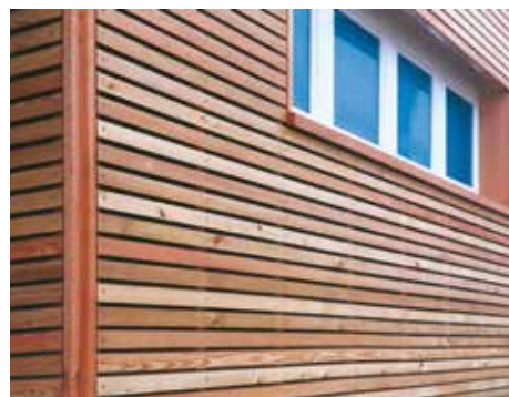
Abb. 1: Aus gestalterischen Gründen werden Fassaden mit Lückenschalung ausgeführt.
