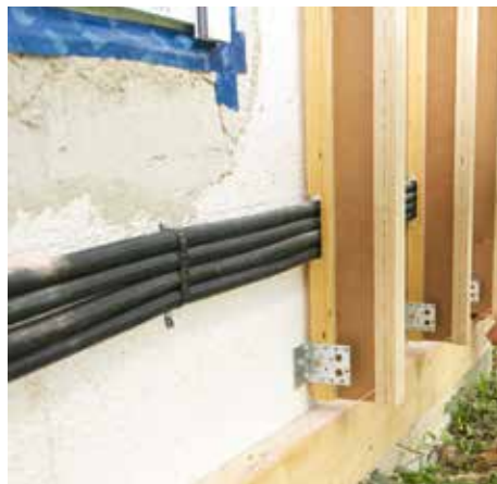
Abb. 4: Im Hinblick auf den Wärmeschutz ist bei größeren Dämmdicken eine Unterkonstruktion aus Stegträgern geeignet. Die Wärmebrückenwirkung wird vermindert. Im Bild ebenfalls zu sehen ist die Führung haustechnischer Installationen in der Dämmebene.
