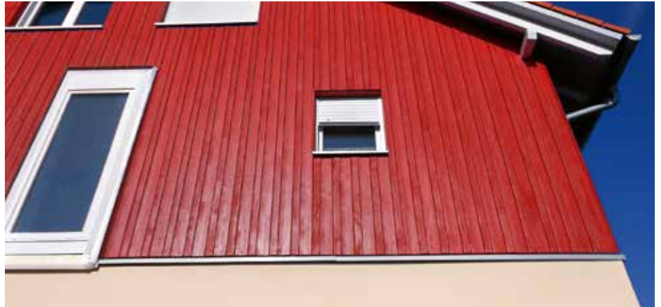
Abb. 1: Eine vorgehängte hinterlüftete Holzfassade kombiniert mit einem Holz-faser-WDVS.
