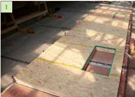
1 Mit SWISS KRONO OSB beplanktes Wandelement auf dem Montagetisch, bei dem noch die Fenster eingesetzt werden müssen.
