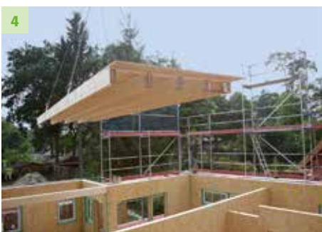
4 Montage der Wand- und Deckenelemente aus SWISS KRONO OSB.
