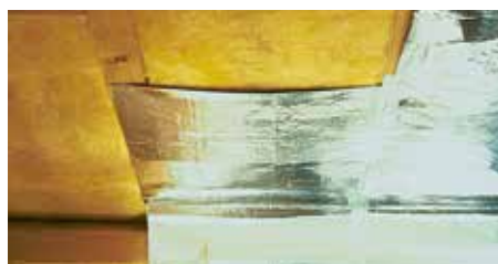
Abb. 3: Kapillar nicht wasseraufnahmefähige Schichten sind z. B. Mineralwolle oder Aluminiumfolie. Fraglich bleibt jedoch, wo das Kondensat (bis 500 g/m 2 ) zwischengespeichert wird. Bild: Ampack
